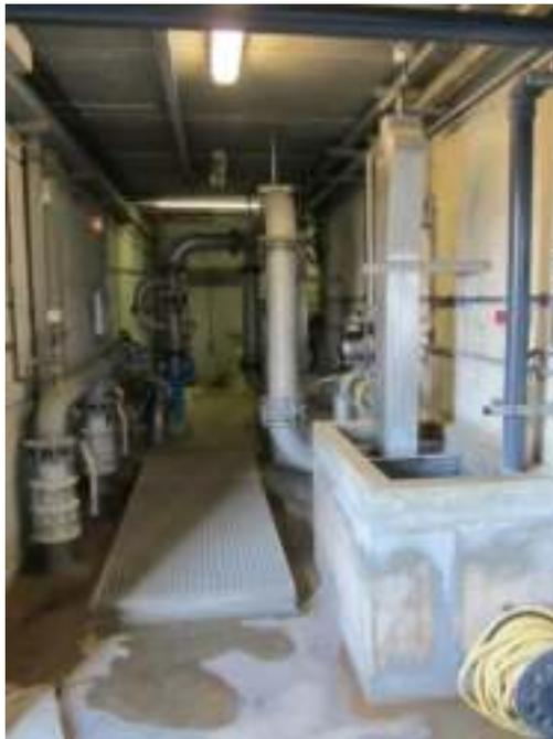
Vue du regard d'accès à la bêche d'eau traitée (enterrée) et des groupes de distribution en arrière-plan
