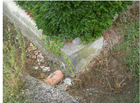
Boite de branchement du particulier qui déborde
