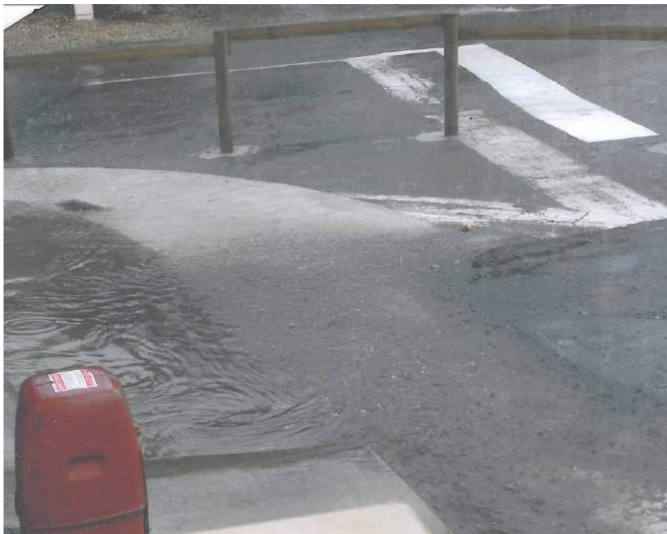
3 Place de Lafeuillade
